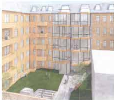
Blick aus dem Park auf Hinterhof und Fassade
