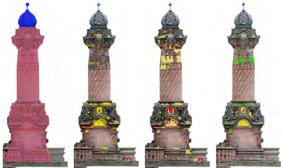
Material-/Fugenkartierung, Schadensarten, -intensität und Maßnahmenkartierung
