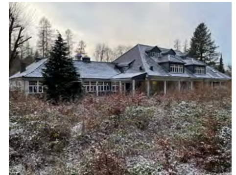
Gesamtaufnahme des ehem. Bahnhofes „Eiserne Hand“
