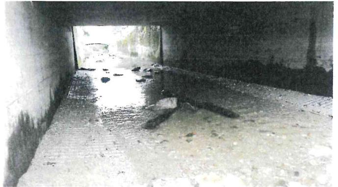
Abb. 6: Gitterrost Benthos-Pass mit Sedimentfüllung (Blick gegen die Fließrichtung)
