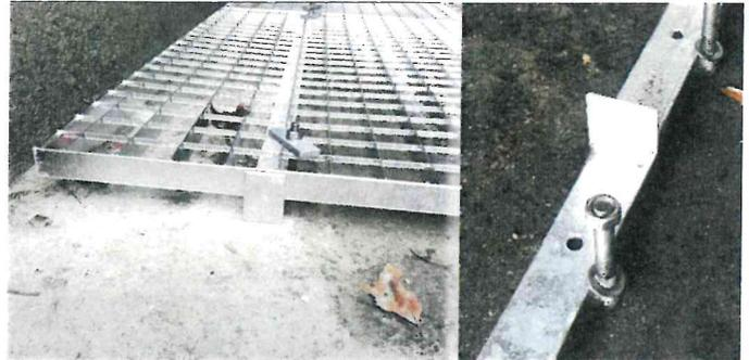
Abb. 4: Strömungstabile Befestigung der feuerverzinkten Press Gitterroste an der Brückensohle
