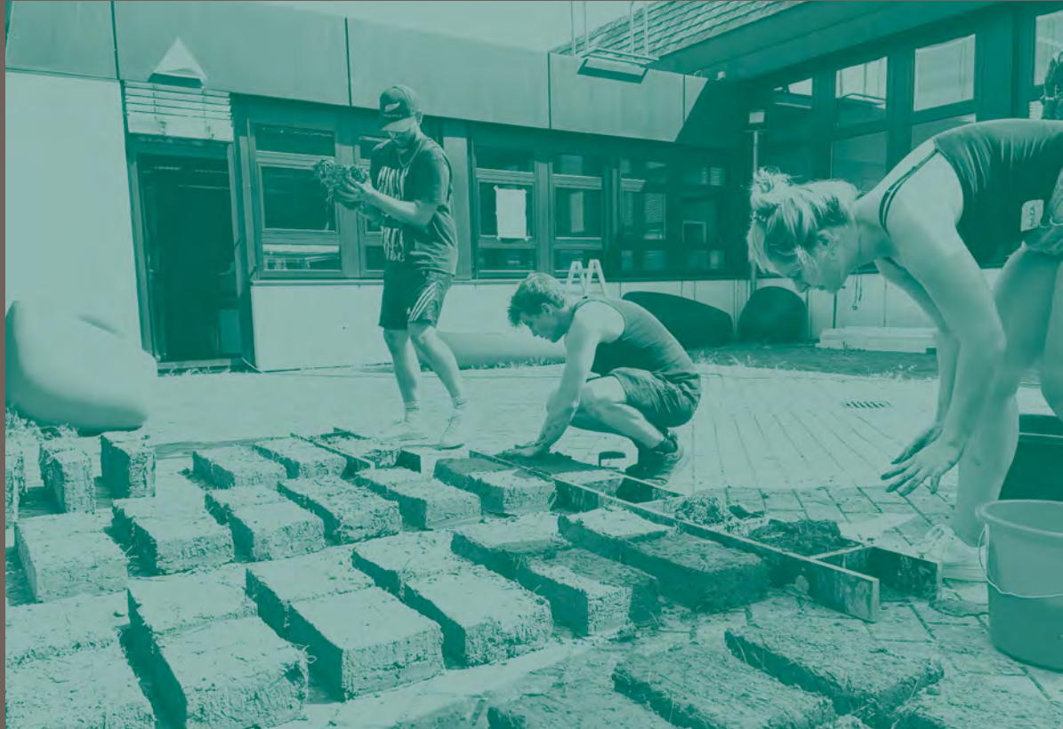
Herstellung der Lehmziegel auf dem Campus Kurt-Schumacher-Ring
