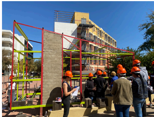
Bauarbeiten beim Vertical Studio
