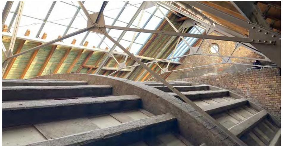
**Eiserne Dachbinder und Eisenbeton-Rippen-Gewölbe mit transluzenten Feldern zur Belichtung der darunter liegenden Schwimmhalle.**
