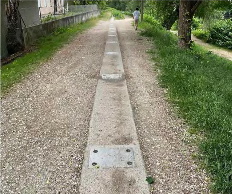
**Integration der Verankerung für mobile Hochwasserschutz Elemente
