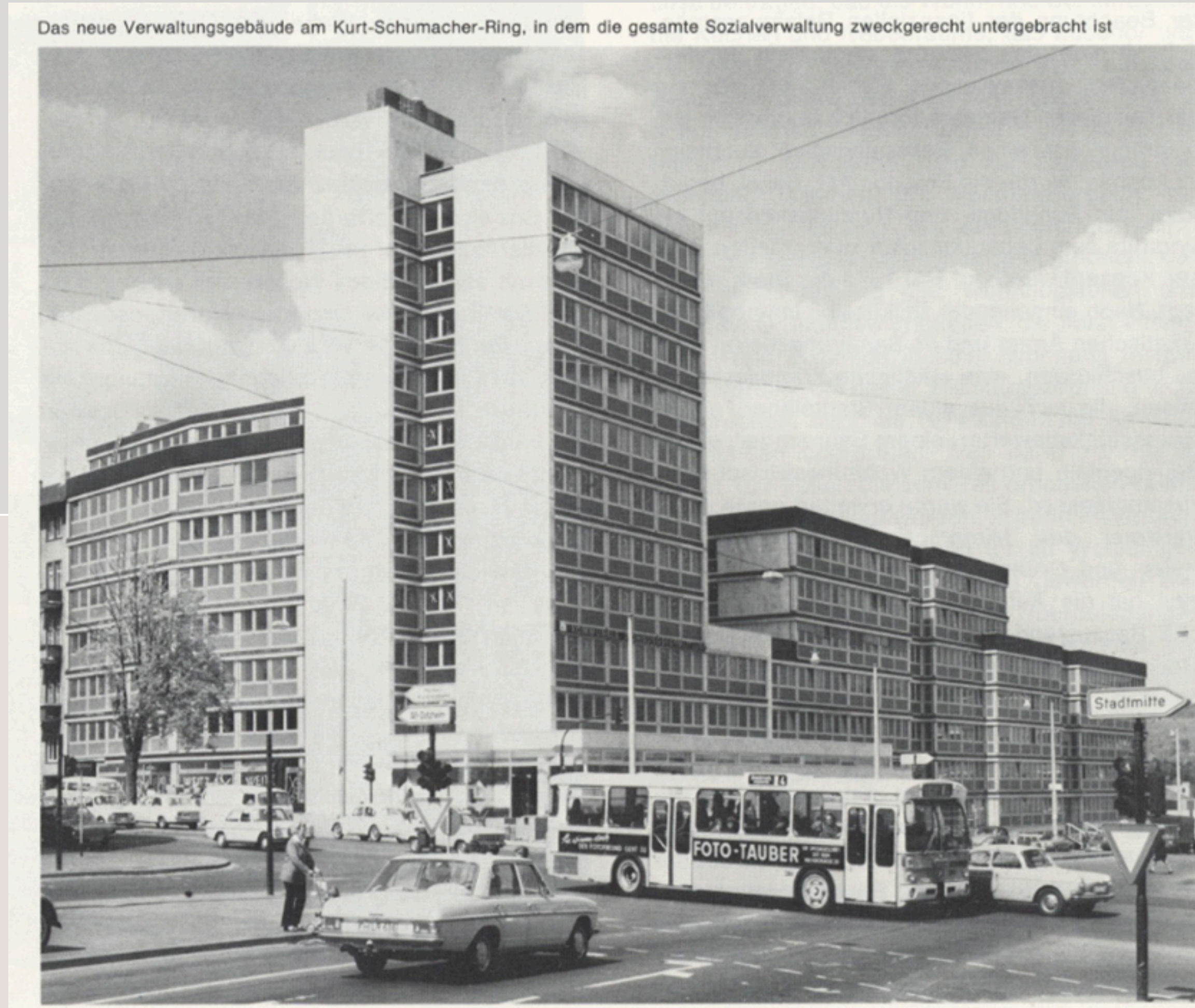
Das neue Verwaltungsgebäude am Kurt-Schumacher-Ring, in dem die gesamte Sozialverwaltung zweckgerecht untergebracht ist
